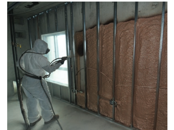
De la mousse à cellule fermée qui est pulvérisée sur tous les étages et dans l'ensemble de l'intérieur du bâtiment.
