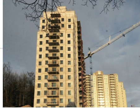
Pose de l'insulthane Extreme, fait à partir du Solstice LBA, dans un complexe immobilier résidentiel situé au 200 rue Carriage, Kitchener, Ontario.
